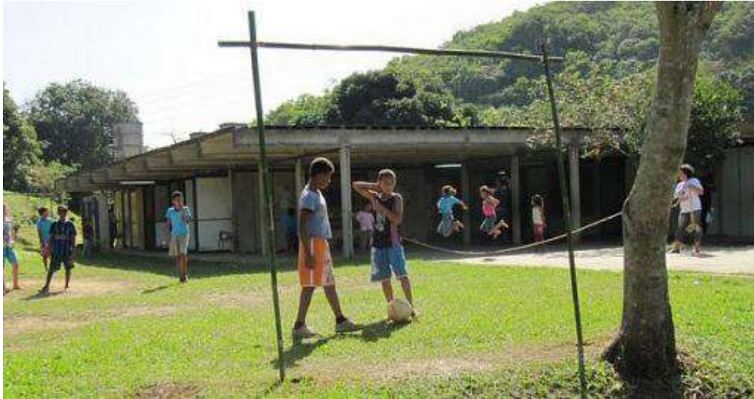
Escuela rural para 50 alumnos, esquema de montaje. Abadiânia (Goiás). Diseño de João Figueiras Lima, década de 1980.
