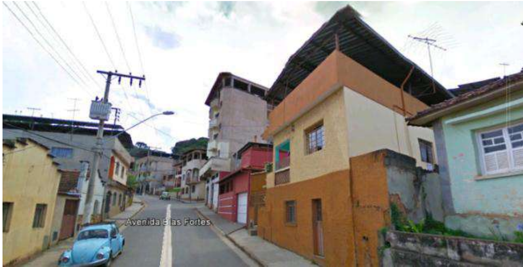
Casas en la ciudad de Congonhas do Campo (Minas Gerais): uso corriente de la terraza cubierta.
