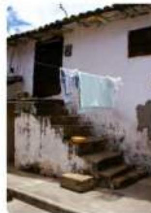
Edificio Principal Antigua Fábrica de Loza año 1989 Imagen: Corporación La Candelaria
