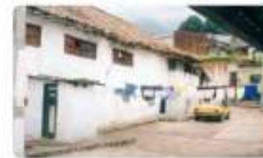
Edificio Principal Antigua Fábrica de Loza año 2001 Imagen: Pontificia Universidad Javeriana
