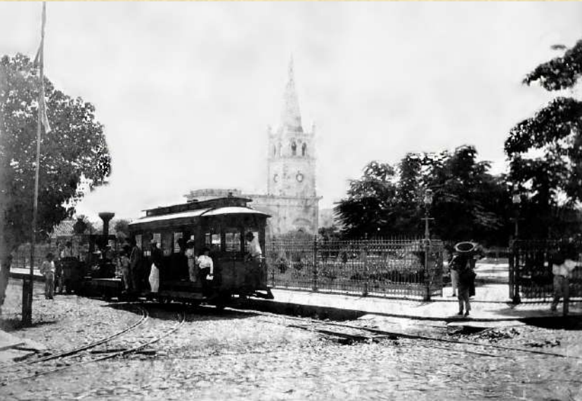
26- Parque Santander. Calle 10 con avenida 6 Se aprecia el tranvía que recorría las calles del centro de Cúcuta. la elegante verja de hierro que encerraba el parque importada de Alemania con 8 puertas y hermosos faroles que lo embellecían aún más. Al fondo la Catedral de San José en construcción, que tenía en esa época solo una torre. 1897.
