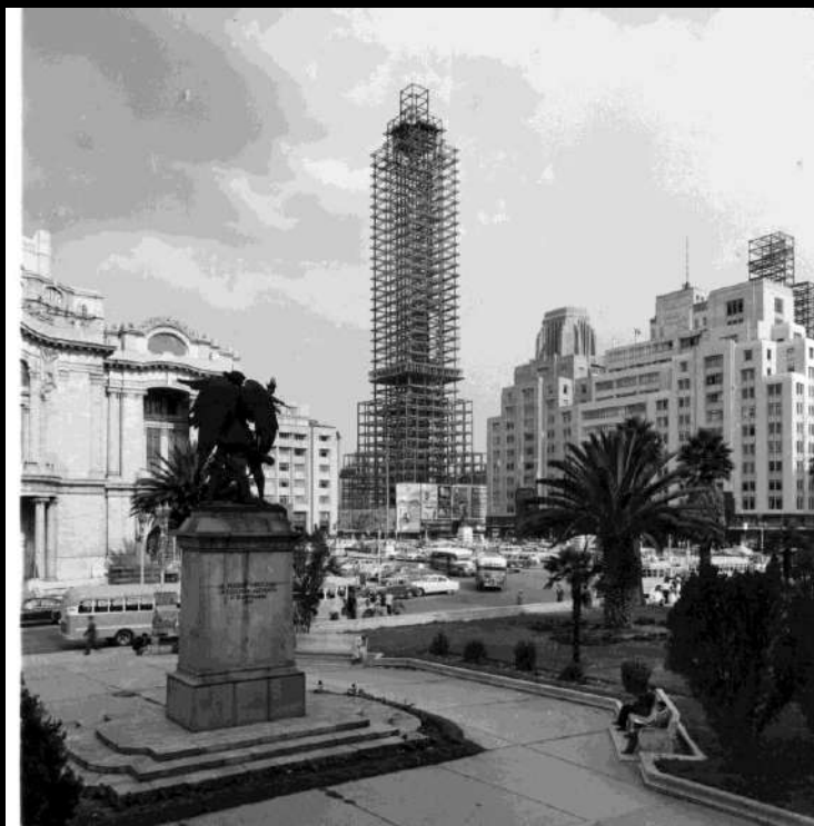
Construcción de la Torre Latinoamericana
