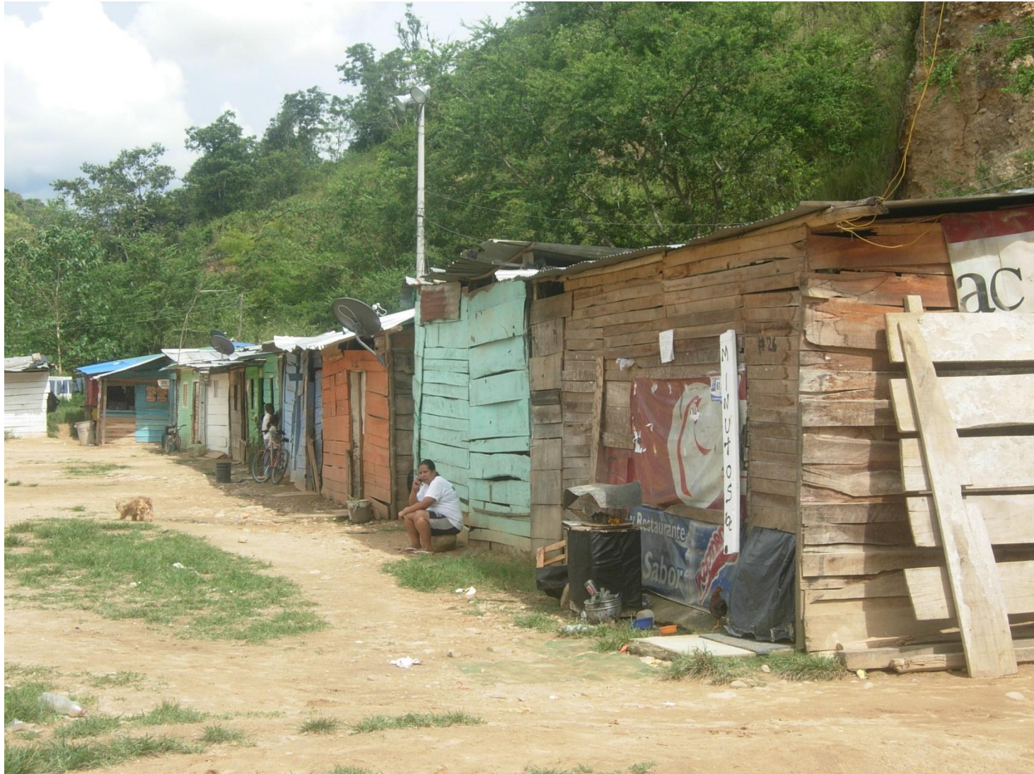
Asentamiento precario “17 de Enero” adjunto a una pared erosiva saturada de agua Municipio de Bucaramanga (Sector Chimitá)
